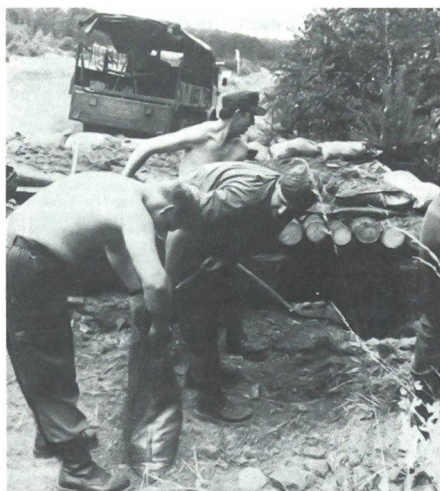
Der Bau von Kampfabweckungen und Beob. Stellen. Dabei wurden zivile Ressourcen genutzt. Der Sand-sack erhielt seine Bedeutung zurück. Foto Truppenzeitschrift
