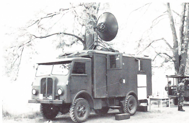
Mit vorwiegend stationären Grossrichtstrahlstationen RB-1111 wurde in den sechziger Jahren das landesweite Richtstrahlnetz aufgebaut. Die betagte Station soll in nächster Zukunft durch die moderne Nachfolgerin R-915 abgelöst werden.
