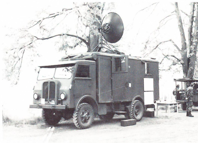
Mit vorwiegend stationären Grossrichtstrahlstationen RB-1111 wurde in den sechziger Jahren das landesweite Richtstrahlnetz aufgebaut. Die betagte Station soll in nächster Zukunft durch die moderne Nachfolgerin R-915 abgelöst werden.
