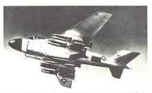
A-6 INTRUDER: das zweisitzige, allwettertaugliche Angriffsflugzeug ist speziell für Angriffe auf Punktziele ausgelegt. Der Pilot und Navigator «Bombenschütze» sind im Cockpit Seite an Seite untergebracht. Die Triebwerke sind am «Bauch» links und rechts in der vorderen Hälfte des Rumpfes untergebracht. Eine Version mit Einsatzrolle «Luftbetankung» heisst KA-6D INTRUDER.
