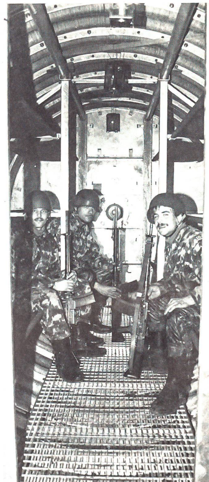
Drei Wehrmänner im neuen Feldunterstand 88 in Sicherheit. Es handelt sich um den vorfabrizierten Schutzbau von Dr Ing Koenig AG, Abt Schutzbauten Bild CH-Soldat I/89
