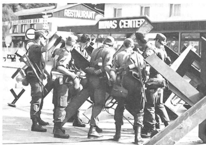
Pioniersoldaten des Bundesheeres errichten eine Sperre mit Panzeriegeln vor einem Grenzübergang.
