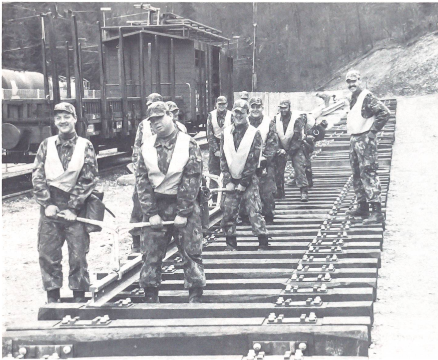
Die ersten vollwertigen Eisenbahnsappeure trainieren in Effingen den Gleisbau. Ohne Teamwork geht hier gar nichts.
