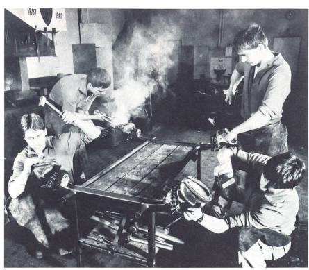
Übungen am toten Huf, eingespannt am entsprechend hergerichteten Werktisch: Ausschneiden von Sohle, Strahl und Hufbeschlagkante; Anpassen des roten Eisens. Die dazu benötigten Hufe werden bei diversen Pferdemetzgereien abgeholt. Alte Ordonnanzeisen stammen aus den Von-Roll-Werken. Es hat immer noch genug davon, obschon die Fabrikation eingestellt wurde.
