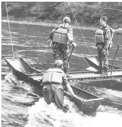
Teamarbeit ist beim Einbau des Stegs 58 unerlässlich.
