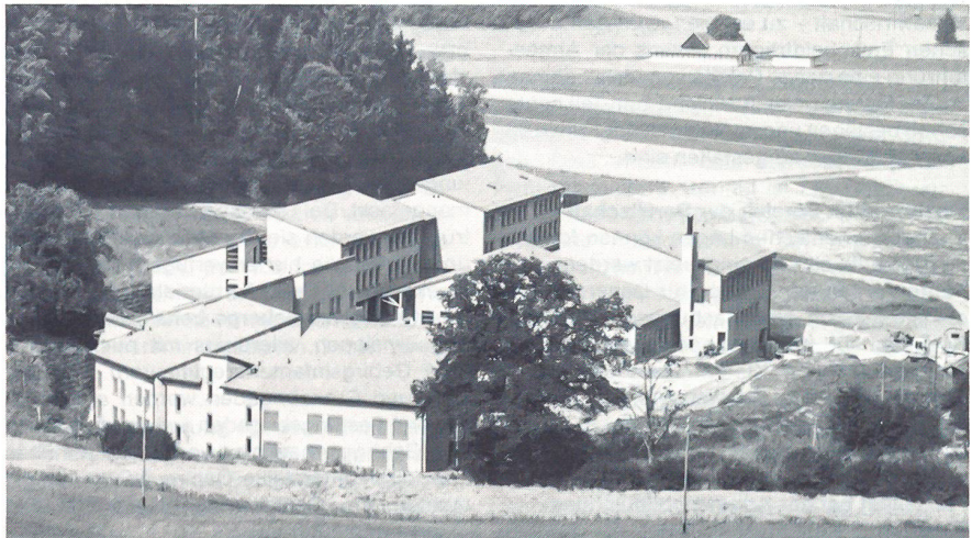
Das Zivilschutz-Ausbildungszentrum in Schwarzenburg ist seit 1984 in Betrieb
