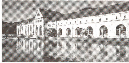
Das Laufkraftwerk Beznau (Oberwasserseitig)
