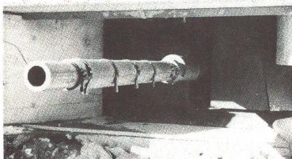
Im neuen Infanteriebunker ist eine 10,5-cm-Pz Kan mit einer Reichweite von bis 1500 m gegen Pz eingebaut. Die Besatzung besteht aus 1 Uof (Bkr Kdt) und 5 Sdt.
