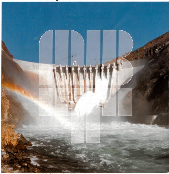
Karakaya-Staudamm in der Türkei: 630000 m<sup>3</sup> Beton mit Rheobuild Superverflüssiger.
