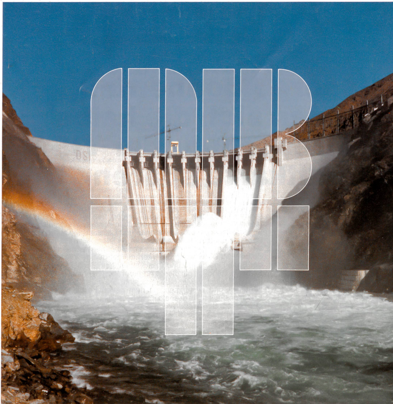
Karakaya-Staudamm in der Türkei: 630000 m 3 Beton mit Rheobuild Superverflüssiger.
