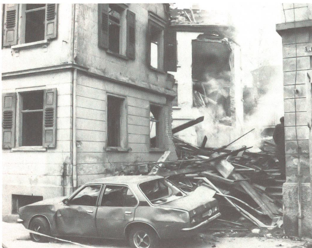
Die Schadenlage ist gross: halbeingestürzte Häuser, demolierte Autos, rauchende Trümmer.
