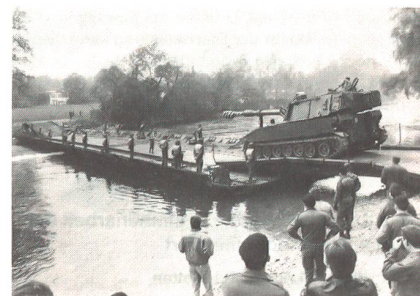
Eine Kompanie des Premier Régiment du Genie de l'Armée française demonstrierte bei Brugg den neuen «Pont flottant motorisé».
