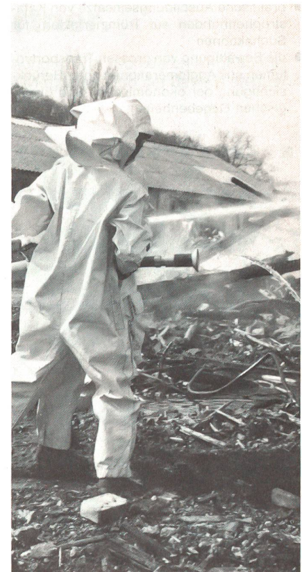
Einsatz in Asbestanzügen.
