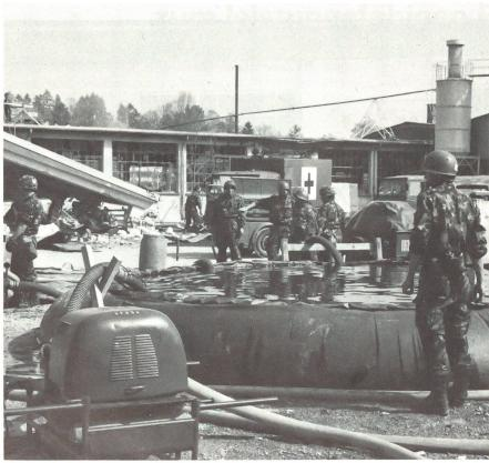
Mit Luft aufpumpbares Reservoir für das Löschwasser.
