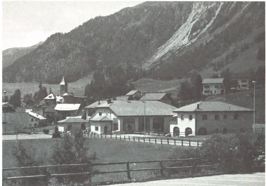
Gesamtübersicht der neuen Anlage. Gut sichtbar die grossen Fenster des Gemeindesaales beim Gebäude links. Im Haus rechts die Abwartwohnung und im Parterre der Kindergarten.
