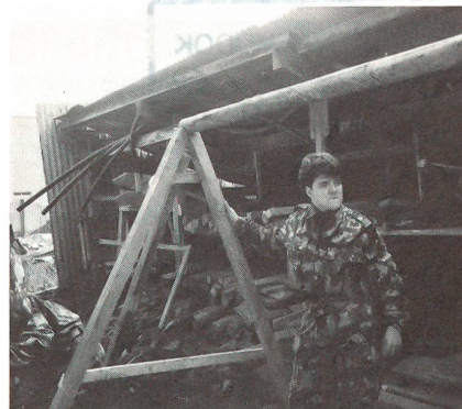
In der Verlegung: Unser Baumeister in Aktion
