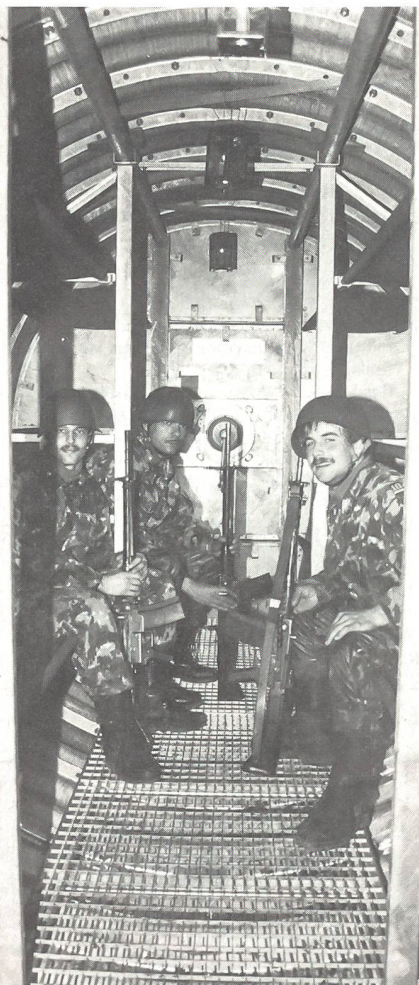
Drei Wehrmänner im neuen Feldunterstand 88 in Sicherheit. Es handelt sich um den vorgefabrizierten Schutzbau von Dr Ing Koenig AG.
