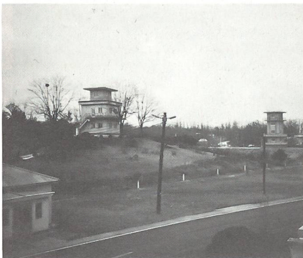
Panmunjom: links ein Gebäude des Verhandlungsgebietes. Mitte und rechts: 2 nordkoreanische Wachtürme. Die Grenze ist mit weissen Pfosten markiert. Im Hintergrund das CH- und Schweden-Camp.
