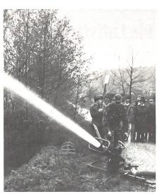
Wasserwerfer 83 im Einsatz (Wassermenge 2000 I/min mit einer Wurfweite von 60 bis 70 m.)
