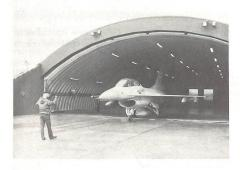
pendienst. Unsere obige Foto zeigt einen F-16B beim Verlassen eines solchen stahlbetonarmierten, erd-überdeckten Flugzeugschutzbaus mit den Abmessungen 21×36×7 m (B×L×H). Gegenüber früheren Shelterbauten zeichnet sich der neue Entwurf durch ein tieferes Profil sowie eine stark modifizierte, nach innen aufgehende Türkonstruktion aus. Die letztere bietet neben einer höheren Betriebssicherheit vor alem auch einen besseren Schutz gegenüber der Wirkung gegnerischer Luft/Boden-Waffen. ka
