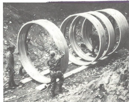
Die Einzelteile des Feldunterstandes werden von der Truppe in der ausgehobenen Grube zusammengebaut. Nachher wird der Unterstand mit dem Aushub zugedeckt.
