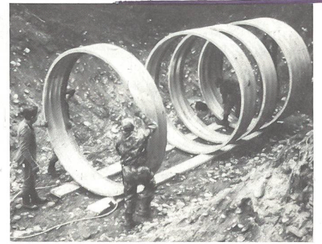
Die Einzelteile des Feldunterstandes werden von der Truppe in der ausgehobenen Grube zusammgebaut. Nachher wird der Unterstand mit dem Aushub zugedeckt.
