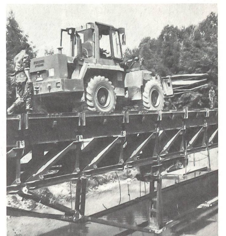
Seit 1987 wird auch die Feste Brücke 69 mit Unterspannung ausgebildet
