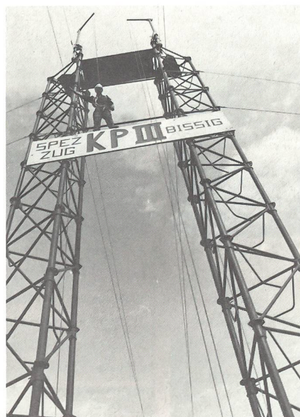
In luftiger Höhe: Stütze zur Festen Brücke 69
