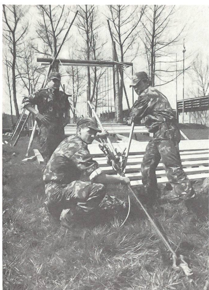
Spannen der Verankerung mit dem Seilzugapparat
