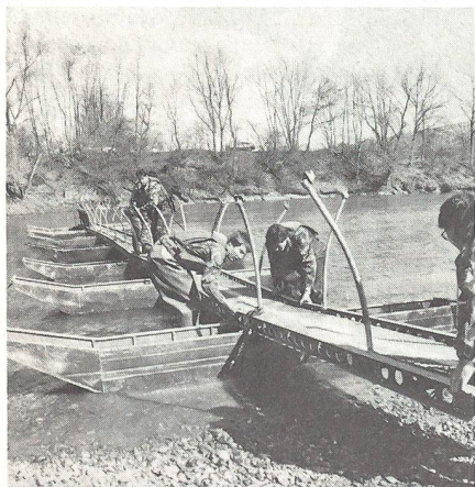
Einschieben der Elemente beim Steg 58
