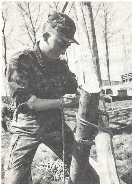
Seilwerk als Verbindungsmittel, die klassische Sappeurkunst
