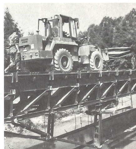
Seit 1987 wird auch die Feste Brücke 69 mit Unter- spannung ausgebildet
