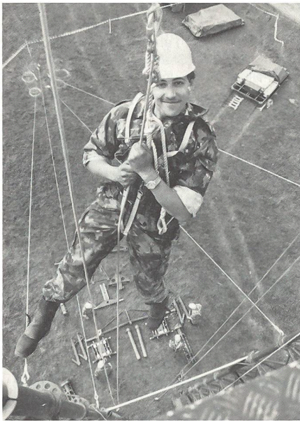
Gut gesichert, in luftiger Höhe, bei der Arbeit an der Stütze der Festen Brücke 69
