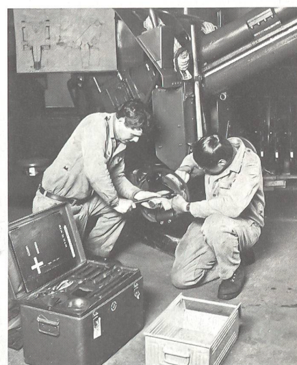
Zwei Geschmechaniker der Mob Artillerie beim Auswechseln der Bremsbacken eines Geschützes.
