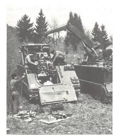
$\hbox{\it Die Panzermechaniker beim Ausbau eines Motores.}$
