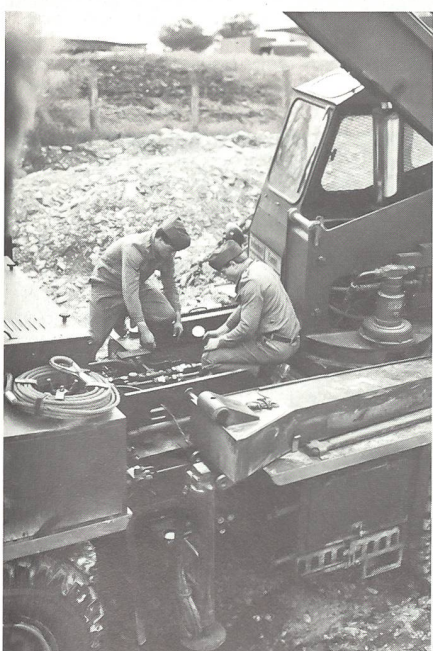
Baumaschinenmechaniker bei den Einstellarbeiten am Motor.
