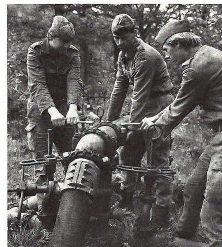
Pioniere des TerrHeeres beim Bau einer feldmässigen Pipeline.
