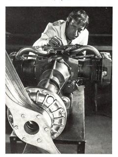
Wie berichtet wird, zeichnet sich der Motor durch ausserordentlich sparsamen Kraftstoffverbrauch aus und erreicht eine Höchstleistung bereits bei relativ geringen Drehzahlen. Er eignet sich daher zum Betrieb von Leichtgeneratoren, Feuerwehrpumpen und hydraulischen Anlagen. In diesen Anwendungen wird zurzeit von Kraftwagenmotoren Gebrauch gemacht, die zu schnell für optimale Leistung laufen. Andere Anwendungen bestehen auf dem Militärsektor und bei Flugzeugen mit Fernantrieb.
