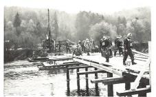
Der Brückenbau ist in vollem Gange. Einbau einer Behelfsbrücke über die Thur.
