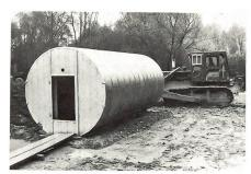
Ein für Feldbefestigungen geeigneter Unterstand aus Normelementen. Im Hintergrund eine schwere Baumaschine im Einsatz.
