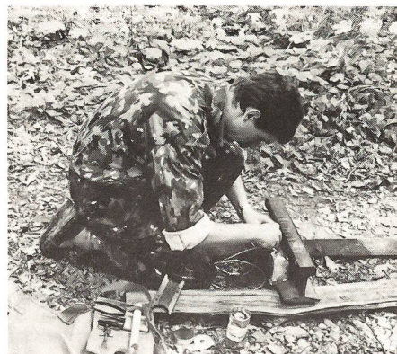
An einer Eisenbahnschiene musste fachtechnisch eine Sprengladung angebracht werden.
