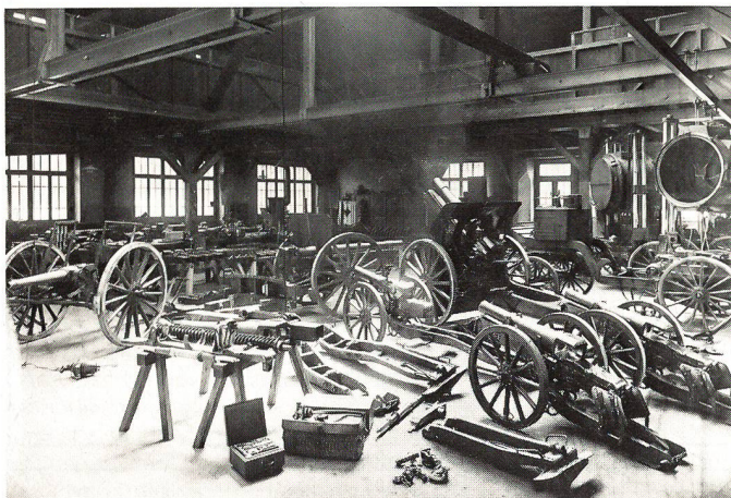
1863 begannen einige Männer in einer Werkstätte Geschütze für die Armee herzustellen ... die heutige K+W (Eidgenössische Konstruktionswerkstätte Thun)
