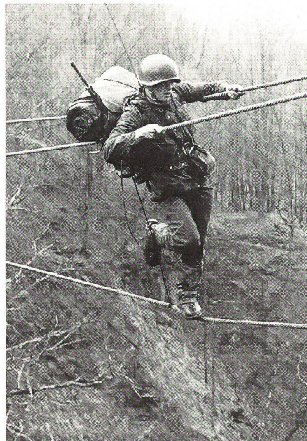
Überquerung einer Schlucht auf dem «Nepalsteg».
