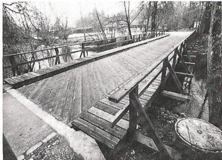
Die neue, von Spezialisten des Genie-Materialkurses erstellte Stränglibrücke hat eine Tragkraft von 18 Tonnen.
