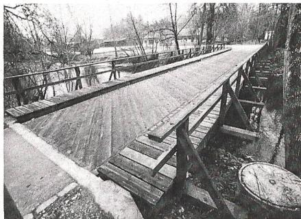
Die neue, von Spezialisten des Genie-Materialkurses erstellte Stränglibrücke hat eine Tragkraft von 18 Tonnen.
