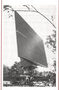
Radar—es sei wieder einmal in Erinnerung gerufen, was das in der Technik so häufig angewandte Wort eigentlich bedeutet. Es wurde aus dem englischen «Radio detection and ranging» zusammengesetzt und heisst Auffinden und Entfernungsmessen mit Radio: Ein Impuls wird ausgestrahlt, vom Zielgegenstand reflektiert (Echo), wieder empfangen und ausgewertet.
