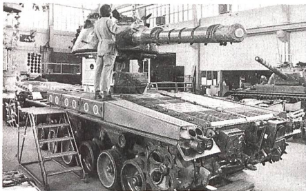
Montagearbeiten beim Panzer 68
