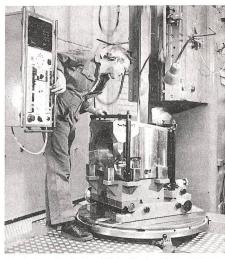
Bearbeiten des Bodenstücks für den Panzer 87 (Leo) mit modernsten Maschinen
