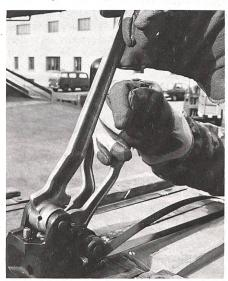
14 «Baverschlapp»-Bandverschliessungsapparat, den ein Munitionssoldat im Palettierdienst beherrschen lernt
