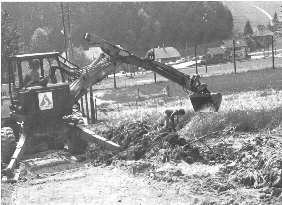
Behebung von Schäden in Fluren und an Strassen
