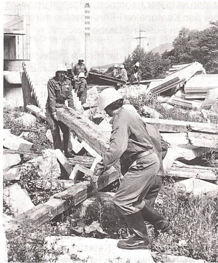
Angehörige der Pionierformationen beim Freilegen von verschütteten Schutzraumeingängen
