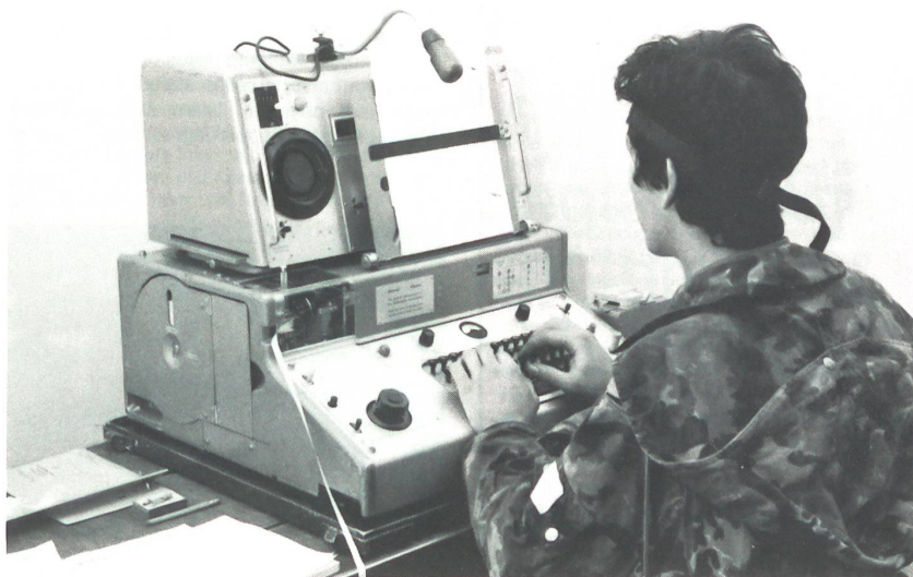
Kryptofunkfernschreiber (KFF) in Betrieb.
