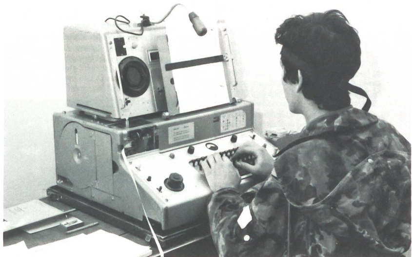
Kryptofunkfernschreiber (KFF) in Betrieb.
