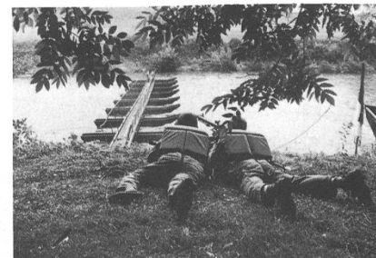
Unter dem Schutz des Maschinengewehrfeuers wird der Steg 58 gebaut.
