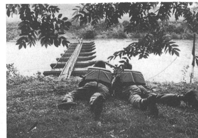
Unter dem Schutz des Maschinengewehrfeuers wird der Steg 58 gebaut.
