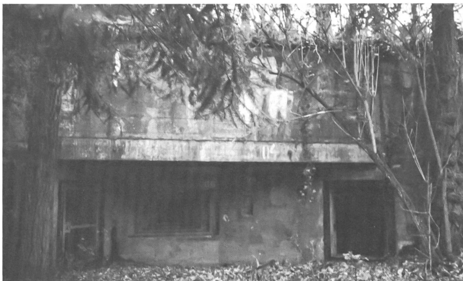
Abb. 4 Gruppenunterstand Limes Regelbau-Typ Nr 10, Eingänge und Scharte der Eingangsverteidigung, Schussrichtung hinter HKL.
