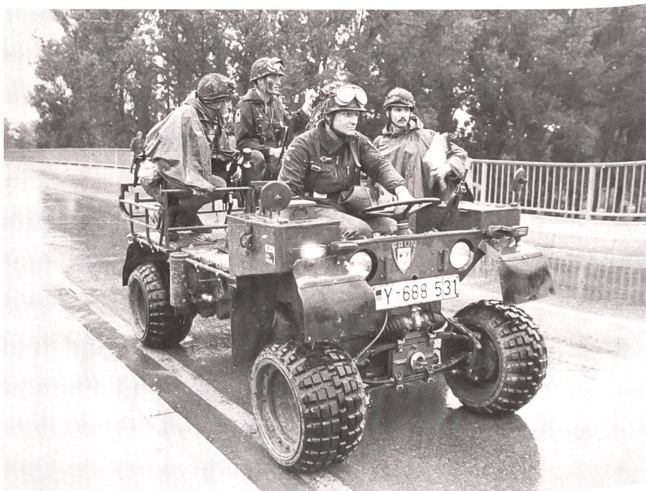
Fallschirmjäger auf dem Marsch mit ihrem «Kraka» (Kraftkarren), einem leichten, 0,75 t schweren, luftverlastbaren Fahrzeug Foto: Gilliar
