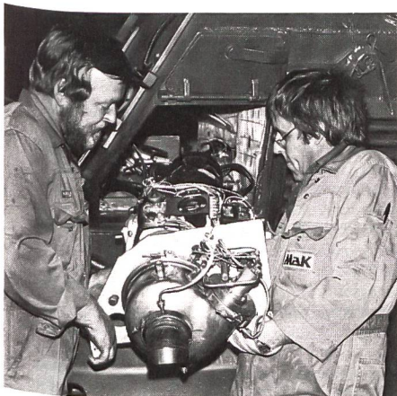
Einbau des Gasturbinen-Stromerzeugungsaggregats an die linke hintere Kettenschulter des Schützenpanzers «Marder».
