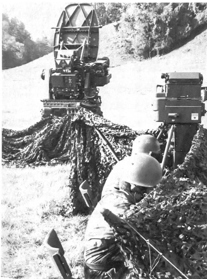
Der Folgeradar (im Hintergrund) und die Bedienungsmannschaft (Bedienungsgerät und optisches Richtgerät) im Vordergrund
