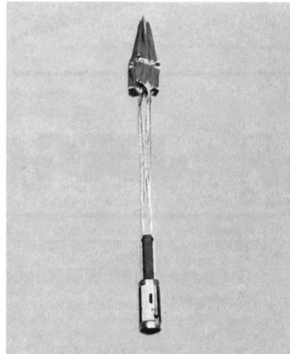
STABO – Tandemladung mit Aufschlagzündung; über Fallschirm gebremster Flug, für das Durchschlagen und Aufwerfen von Betonflächen.
