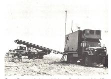
Scout Drone mit dazugehörigem Startkatapult im Hintergrund und Einsatzleitfahrzeug im Vordergrund. Links im Bild eine getarnte Scout Drone. Die Drone kann via Katapult als auch von herkömmlichen Startund Landepisten gestartet werden.
