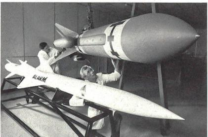
Diese Modelle voller Größe geben einen Begriff von zwei der fortgeschrittensten Lenkwaffen der Welt, die im Rahmen von Programmen der British Aerospace entwickelt werden. Die «Sea Eagle» ist eine über dem Meer gleitende Luft-Schiff-Rakete, während die «Alarm» der Ausschaltung feindlicher Radargeräte dient. Beide Systeme sind für die Royal Air Force bestimmt.
