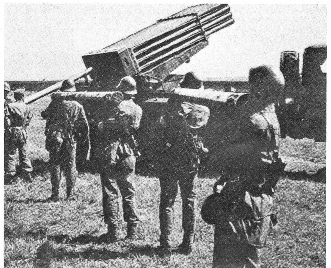
Bild oben: Ungelenkte Artillerieraketen vom Kaliber 12,2 cm. Feststoffantrieb. Splitterwirkung oder C-Kampfstoff-Füllung. Beachte die Länge der Munition (Gewicht, Transportproblem).
