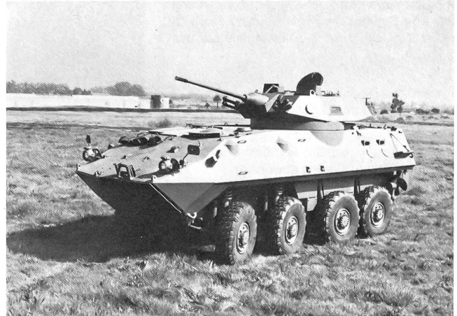
Piranha 8x8, ausgerüstet mit der neuen Hughes 25 mm Bushmaster Kanone für die US Army und die US Marines
