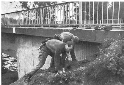
Brücke wird zur Sprengung vorbereitet
