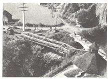
In nur drei Stunden haben am 19. September 1984 25 Mann der (insgesamt 114 Mann zählenden) 1. Sappeur-Kompanie unter Hauptmann Tachini eine Eisenbrücke über dem Ticino in Stalvedro, südlich von Airolo TI, errichtet. Der «Ponte 69 fisso» von der Breite eines mittleren Lastwagens ist 28 m lang und bis zu 50 Tonnen belastbar. Die Einbahn-Eisenkonstruktion kann in je drei Stunden auf- oder abgebaut werden.
