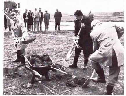
...die Zeremonie des ersten Spatenstichs in Frauenfeld vom 3. Mai 1983. – Von links: Regierungsrat Dr Felix Rosenberg, Militärdirektor des Kantons Thurgau, H Bachofner, Stadtpräsident von Frauenfeld, und E Meuter, Projektleiter des Waffenplatzes.
